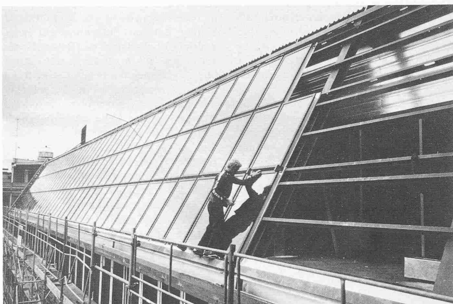
Das Sonnenkollektorenfeld für die Brauchwasserheizung auf dem westlichen Gebäudetrakt. Die Kollektoren bilden gleichzeitig die Dachhaut
