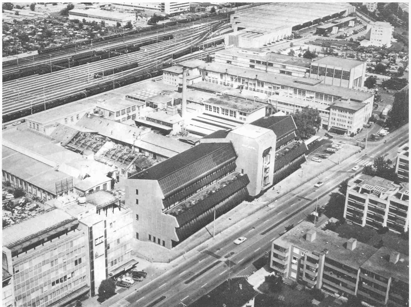
Flugaufnahme der Gesamtanlage von Südwesten
