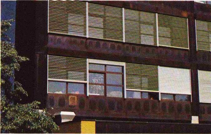
Bild 8. Unregelmässige Färbung von Fassadenelementen, verursacht durch unterschiedliche Wärmeableitung (und damit unterschiedlich lange Feuchtperioden) an Stellen, wo im Elementinnern Stege als Abstandhalter angeheftet waren
