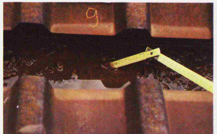
Bild 13. Dachrinne mit zu geringem Gefälle, fast vollständig angefüllt mit Wasser und schlammartigen Korrosionsprodukten
