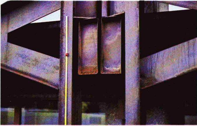
Bild 1. Fassadenausschnitt, Stahlskelettbau mit zahlreichen Stellen, wo das Regenwasser längere Zeit liegen bleiben kann
