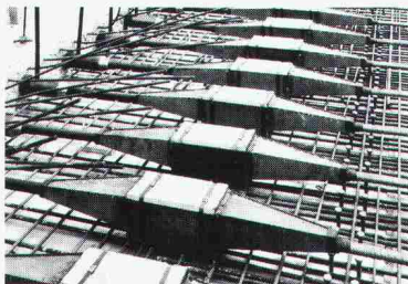
Vorfabrizierter Träger mit beweglicher Verankerung Typ A 2350
