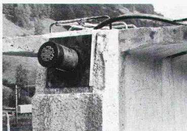
Vorfabrizierter Träger mit beweglicher Verankerung Typ A 2350
