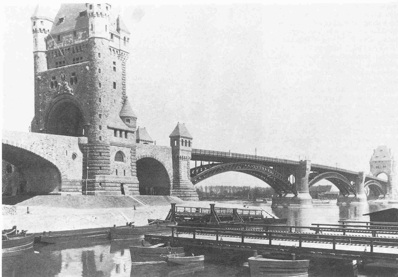
Nibelungenbrücke bei Worms (1897)
