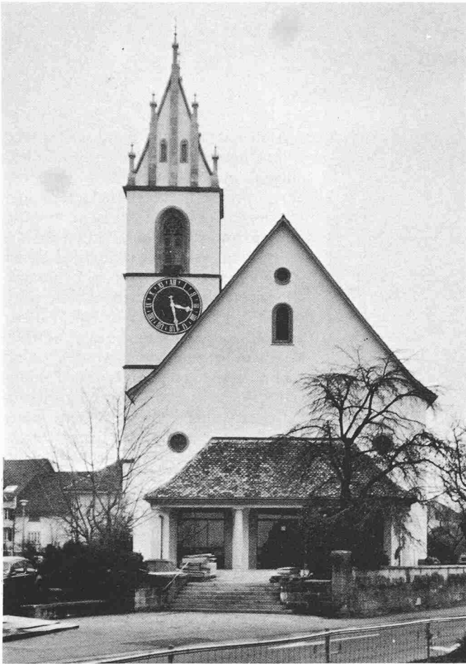
Bild 11. Westansicht der Kirche Meilen nach der Renovierung 1978
