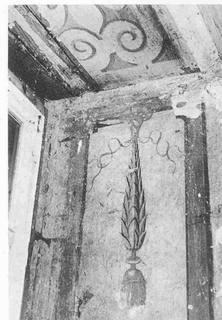
Fachwerzimmer im Hochparterre: Detail Fenster- nische vor der Restaurierung
