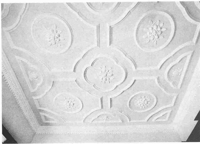
Prunkzimmer im Obergeschoss: mit Früchten bereicherte Stuckdecke
