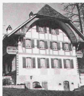
Der Wärmedämmputz eignet sich bei Renovierungen hervorragend (Riegelbauten)
