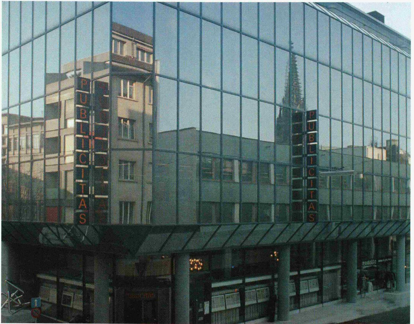
INFRASTOP - Sonnenschutz - Isoliergläser mit den hervorragenden k-Werten bis zu  $1,4 \text{ W/m}^2\text{K}$  werden in allen Farbnuancen hergestellt, für hellspiegelnde farbakzentuierte Fassaden (in Ausresin, Gold, Bronze oder Silber) bis zu den Sonnenschutzfassaden ohne Reflexion und Farbwirkung (Grau oder Neutral). Die Konzeption grosszügiger Glasflächen bis zur Ganz-
