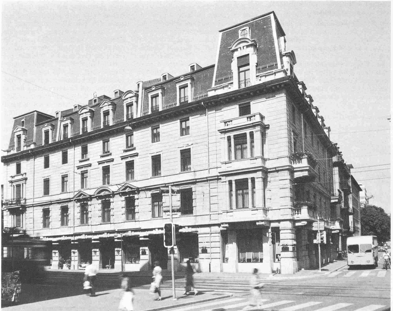
Die Bank Hofmann am Bleicherweg in Zürich nach der Renovation
