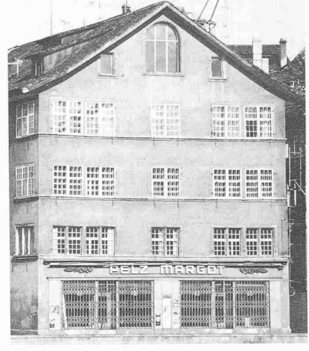
Das «Neuhaus» vor der Restaurierung 1976
