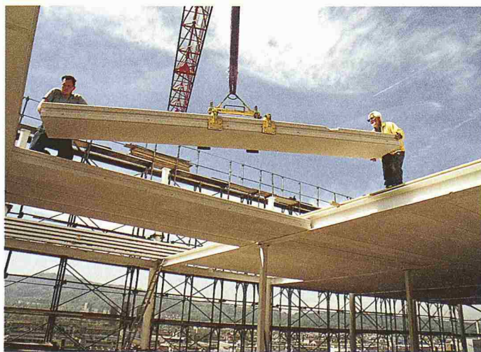
Verlegung von 5 m langen Ytong-Deckenplatten bei der Aufstockung des Phoenix-Hochhauses
