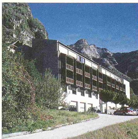
Ansicht von der Talseite (Süden), jedes Zimmer verfügt über eine eigene Lobbia
