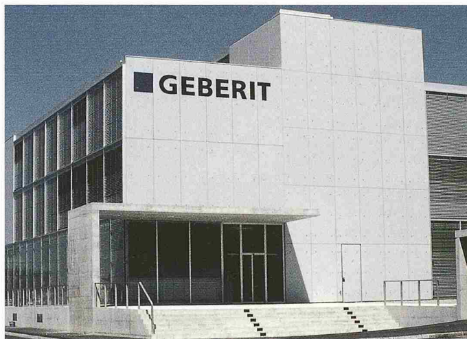
Die moderne Industriearchitektur des neuen Geberit-Informationszentrums stammt von Theo Hotz. Mehr als 4000 Fachleute und Auszubildende lernen hier jährlich die Verarbeitung und Handhabung der Geberit-Produkte kennen (Bilder: Geberit Vertriebs AG)
