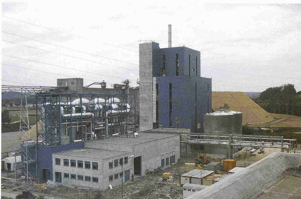
Die Cellulosefabrik Atisholz AG liefert gratis Abwärme (Bild: Solothurner Zeitung)
