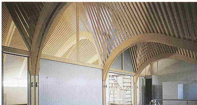
Die Holzkonstruktion des neuen Dachstuhls in der Ferme du Manoir in Nyon
