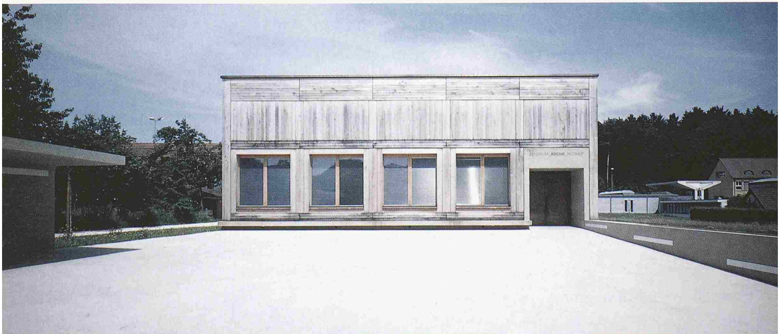
Hauptfassade Süd (Bilder: Markus Jüngling, Basel)
