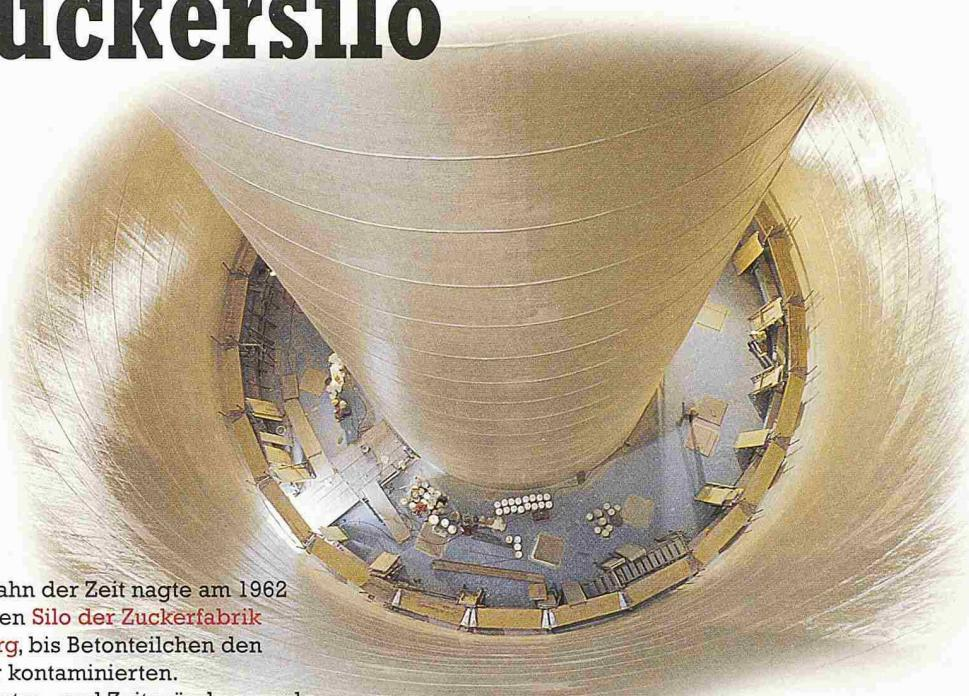
Der Zahn der Zeit nagte am 1962 erbauten **Silo der Zuckersfabrik Aarberg**, bis Betonteilchen den Zucker kontaminierten. Aus Kosten- und Zeitgründen wurde die Sanierung einem Neubau vorgezogen. Ein Fall für SikaBau Kirchberg BE:
