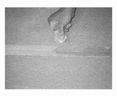
Einpressen der Lamelle in den mit Epoxidkleber verfüllten Schlitz
