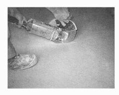
2 Einschlitzen des Traggrunds mit der Fräse
