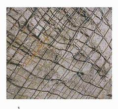
Zerstörter Beton und freigelegte Armierung nach Brandbelastung
