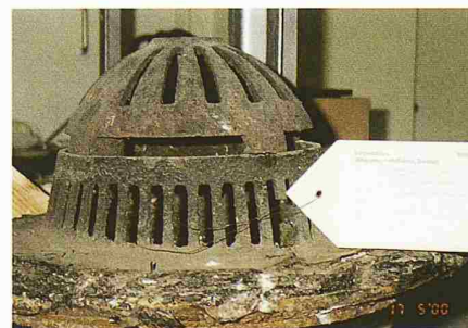
Detail zur Dachentwässerung. Datierung 1976
