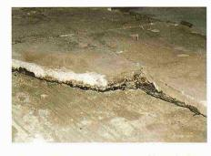
Detail Aufbau Dachterrasse 1976. Keramische Platten in Asphaltschicht auf Betondecke
