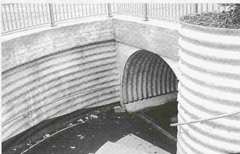
Fuss- und Radweg Unterführung Umfahrung Willisau
