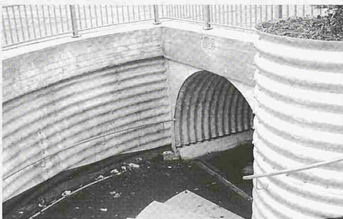
Fuss- und Radweg Unterführung Umfahrung Willisau
