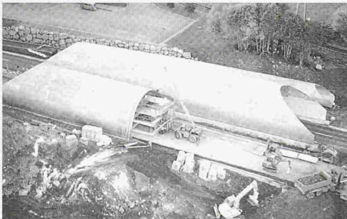
Wellstahlprofil 10,60/7,60 m Wildüberführung A8 Schindellegi
