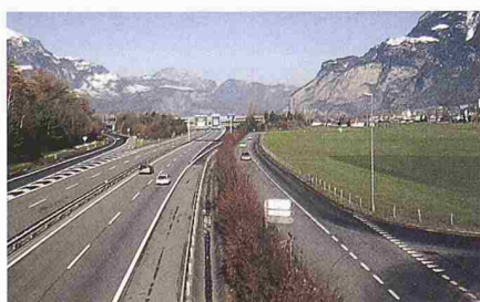
4.1, 4.2 Hochwasserschutzmauer: vorher (unten) – nachher (rechts)
