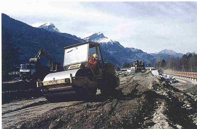
1 Klassischer Dammbau bei der Dammverschiebung unterhalb Brücke Seedorf
