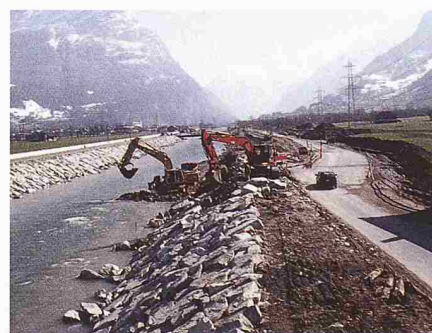
Verschiebung des Reussdammes (Bild: Irène Elber)
