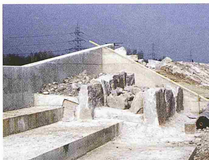
3 Entlastungsanlage Altdorf während des Baus (links)
