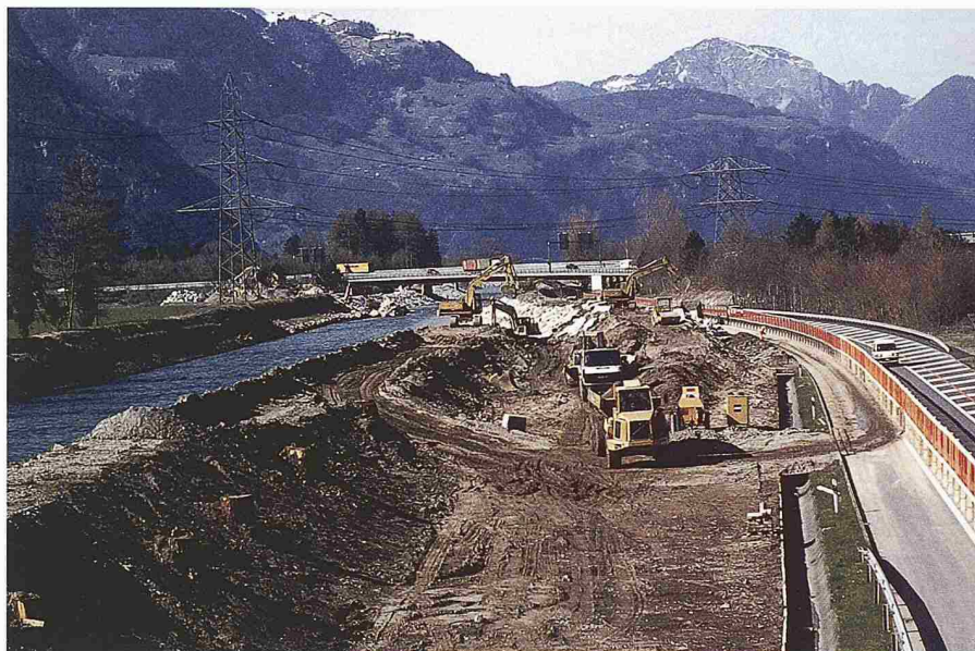
Verschiebung des Reussdammes (Bild: Irène Elber)
