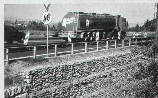
Verlängerung der Ausfahrt A1 Rastplatz Kölliken Süd, Böschung- sicherung
