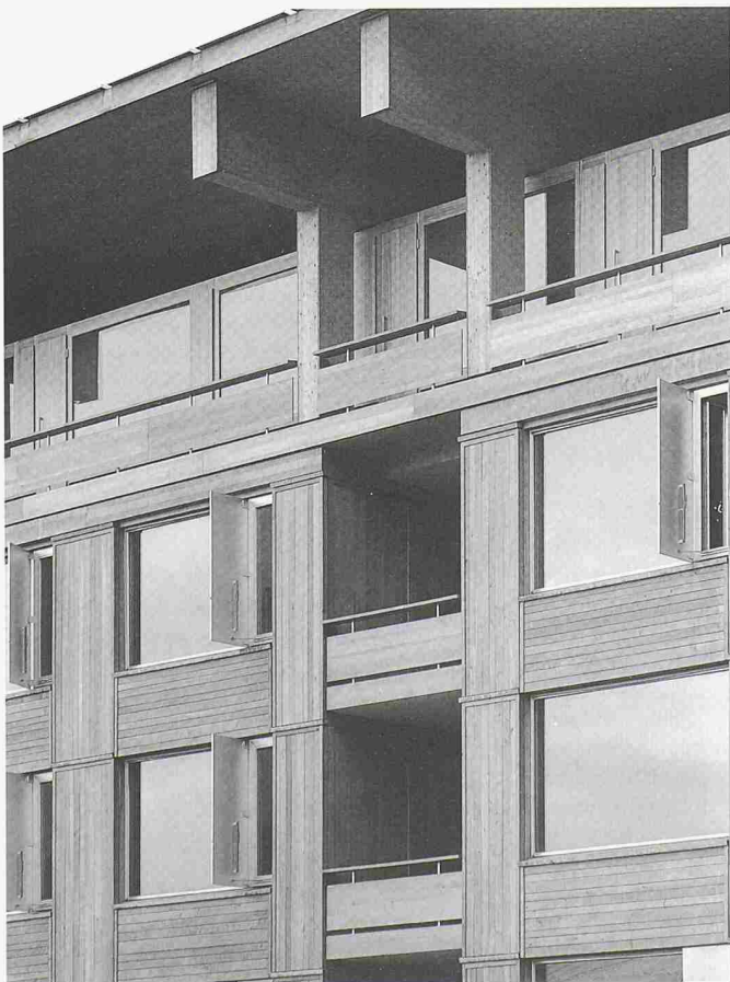
Das neue Lehrgebäude der SH-Holz sorgte weit über die Grenzen der Schweiz für Aufsehen. Für die Teilnehmer des Nachdiplomstudiums Holz ist es ein idealer Ort, um sich mit den Möglichkeiten des Holzhausbaus auseinanderzusetzen (Bild: Hansruedi Riessen)
