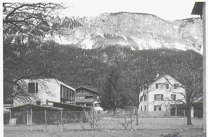
Haus Bottaholds. Situation, Südansicht
