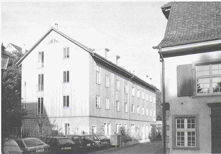
Mehrfamilienhaus St. Albantal, Basel, 1986/87
