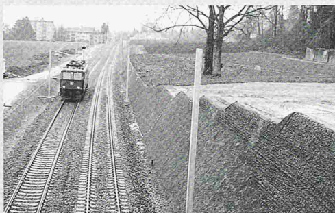
60° Steil- böschung neue Doppelspur MThB Kreuzlingen.
