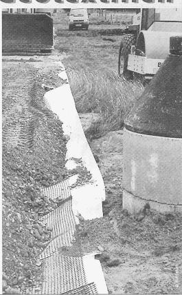
Vliesstoffe zum Trennen, Filtern und Schützen.
