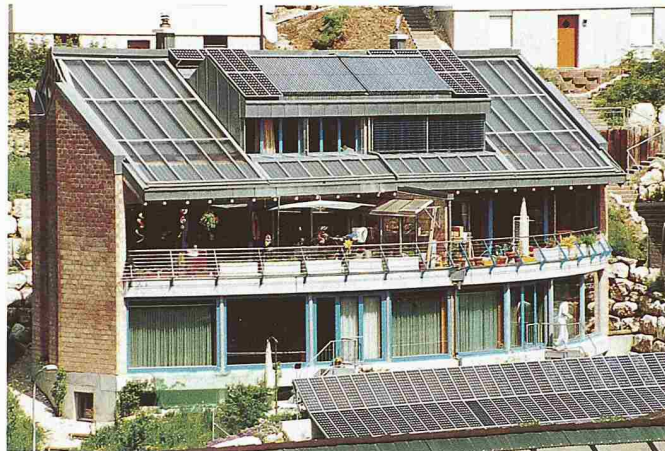
Vier-Familien-Solarhaus in Oberdorf BL, Solartechnik Holinger Solar AG
