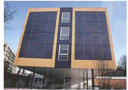
Photovoltaik-Fassade Rhodanie, Lausanne 2000. Planung: Seviles Industrielles de Lausanne (Bild: Net AG, St. Ursen)
