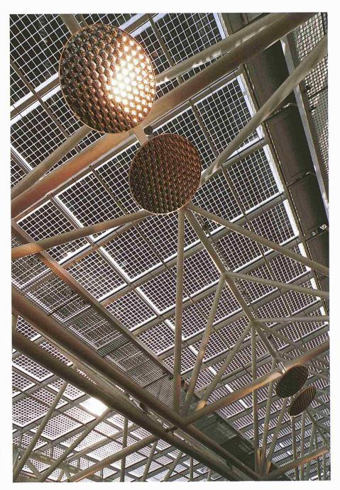
Migros Limmatplatz, Zürich 1999. Dachintegrierte 31 kWp-Anlage mit Photovoltaik-Isolierglas-Modulen. Planung: Energiebüro Zürich (Bild: Energiebüro Zürich)
