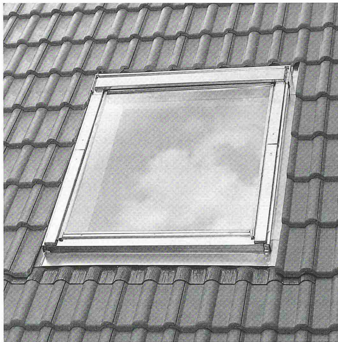
Verbesserte Integration ins Dach dank einem um 27 mm tieferen Einbau – die neue Dachfenster-Generation von Velux
