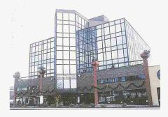
Oben: Einer der ersten Bauten mit hochgedämmter Hülle und angepasster Haustechnik. Energiekennzahl Wärme < 140 MJ/m² y. (Bauherr: Messerli AG Wetzikon, 1988/89, Architekten: Sattler Architekten, Wetzikon; Bild: Autor)
