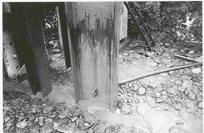
Das einvierte Profil wird gezogen und die Suspension injiziert
