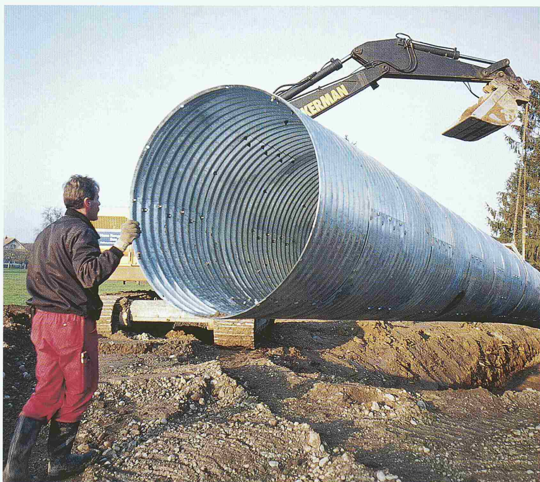
Montage eines HAMCO-Wellstahlrohres in Ermensee, Kt. Luzern.
