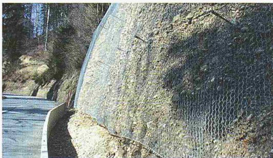
Passiver Stein- schlagschutz auf der Hulftegg SG
