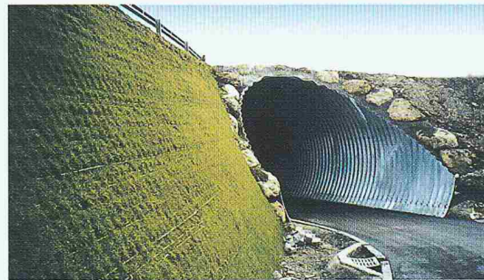
Geh- und Radweg- unterführung Staatsstrasse Nr. 13 Wil-Wattwil
