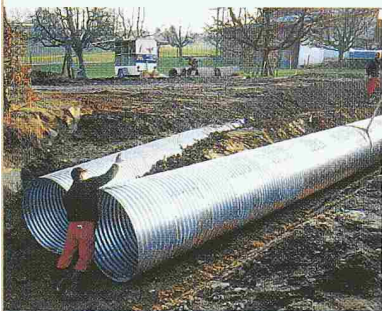
Montage eines HAMCO-Wellstahlrohres in Ermensee, Kt. Luzern.
