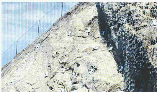
Aktiver Steinschlagschutz in Küssnacht
