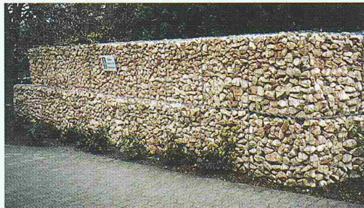
Lärm- und Sichtschutz Saunalandschaft Kurbad Reinfelden
