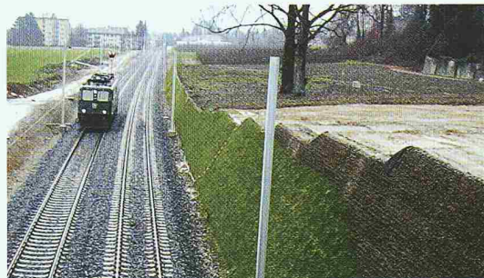
60° Steil- böschung neue Doppelspur MThB Kreuzlingen
