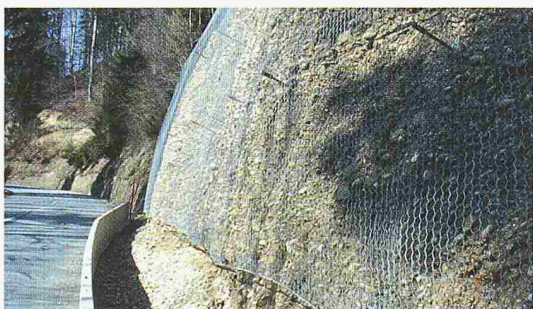
Passiver Stein- schlagschutz auf der Hulftegg SG
