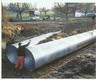
Montage eines HAMCO-Wellstahlrohres in Ermensee, Kt. Luzern.
