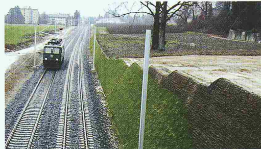
60° Steil- böschung neue Doppelspur MThB Kreuzlingen
