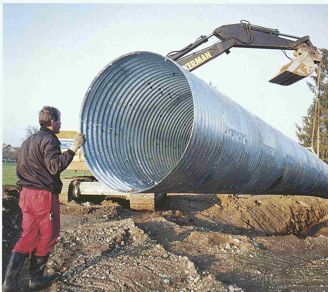
Montage eines HAMCO-Wellstahlrohres in Ermensee, Kt. Luzern.
