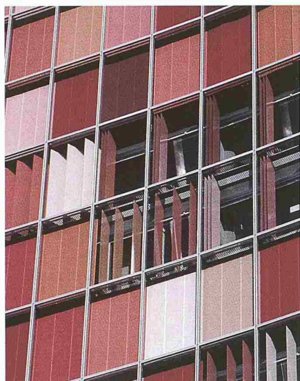
Ausschnitt Westfassade mit Sonnenschutz: rot-geölte Paneele, zum Teil offen und geschlossen
