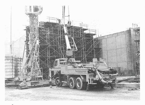
Die 13 m hohen Wände wurden mit Recycling-Pumpbeton in einer Etappe erstellt
