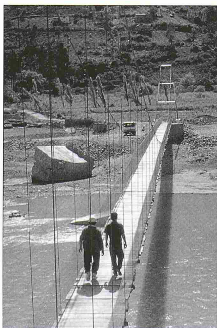
Die Brücke über den Río Paute in Ecuador hat eine Spannweite von 100 m
