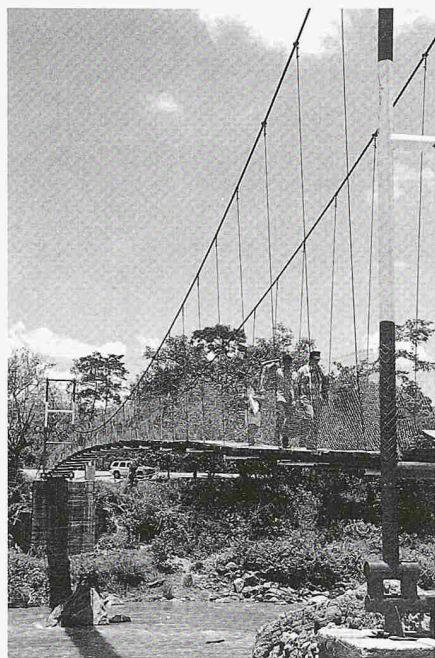
Die Brücken werden stets nach dem selben System gebaut. Im linken Bild ist in der unteren rechten Ecke die gelenkige Lagerung des Pylons sichtbar. Bei grösseren Spannweiten würde die Brücke zusätzlich mit horizontalen, in der Ebene parabolisch gespannten Seilen zur Aufnahme der Windkräfte ergänzt
