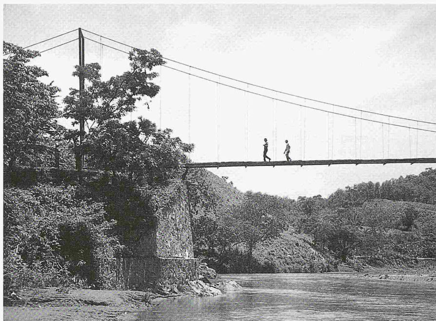
Die Brücken werden stets nach dem selben System gebaut. Im linken Bild ist in der unteren rechten Ecke die gelenkige Lagerung des Pylons sichtbar. Bei grösseren Spannweiten würde die Brücke zusätzlich mit horizontalen, in der Ebene parabolisch gespannten Seilen zur Aufnahme der Windkräfte ergänzt
