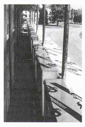
StoFassadendämmplatten, mit Gerüstfolie Safety am Gerüsthandlauf befestigt
