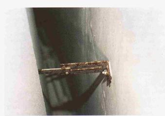
Bauteile aus verzinktem Stahl aus demselben Hallenbad wie die in Bild 5 dargestellten Befestigungselemente aus nicht rostendem Stahl. Nur an den Schnittkanten sind vernachlässigbare Korrosionserscheinungen sichtbar
