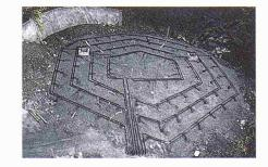
Aufsicht auf ein Feld von vertikalen Erdwärmesonden, wie sie prinzipiell zum Einsatz kämen Wärmeübergabestationen an die Gebäude abgegeben.
