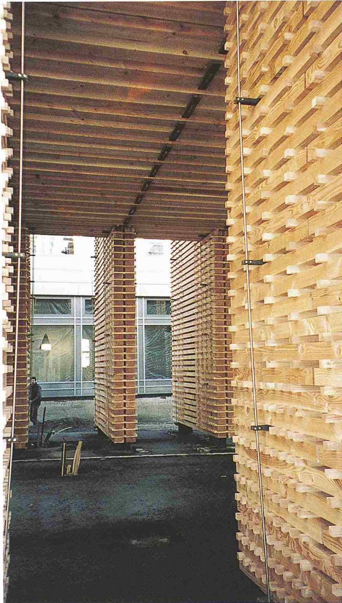
Stapelwände mit Zugstangen
