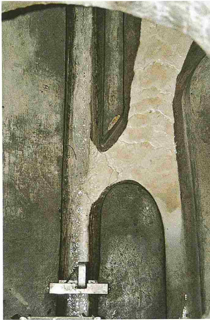
4 Versinterungsbeispiel (links behandelt, rechts unbehandelt): Hangwasserfassung
