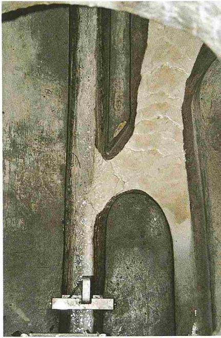
4 Versinterungsbeispiel (links behandelt, rechts unbehandelt): Hangwasserfassung
