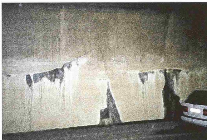
5 Wassereintritte durch Risse im Tunnelgewölbe infolge Wasserdruckaufbau
