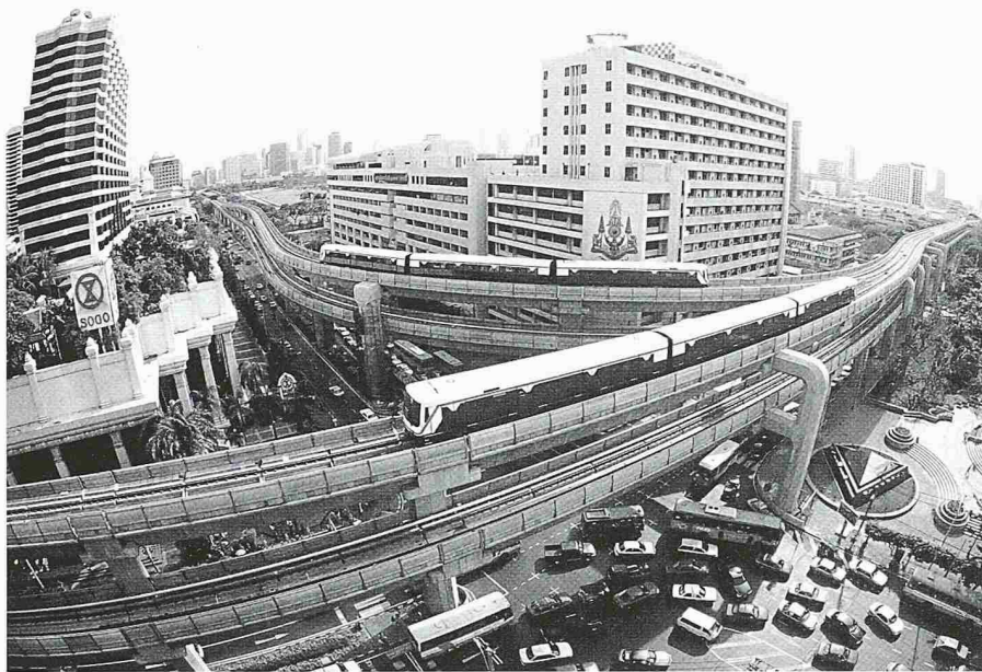
«Skytrain», die neue Hochbahn von Bangkok
