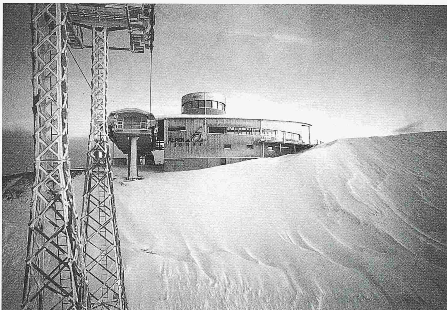
Bergrestaurant Planplatten, Meiringen-Hasliberg (Architektur: E. E. Anderegg + Partner Architekten AG, 1999). Blick von der Ankunftsseite der Gondelbahn
