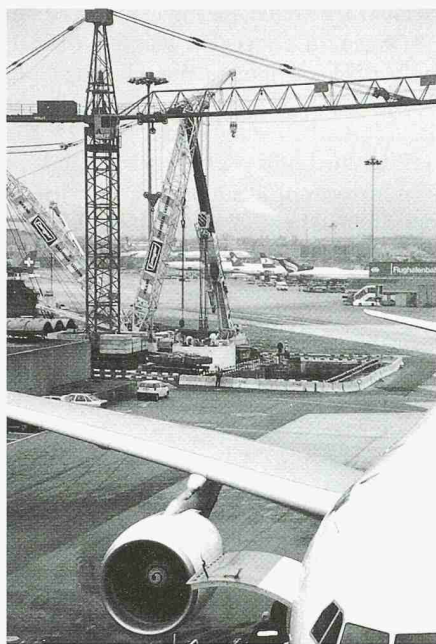
Blick vom Fingerdock B in Richtung Startschacht während der Montage der Tunnelbohrmaschine
