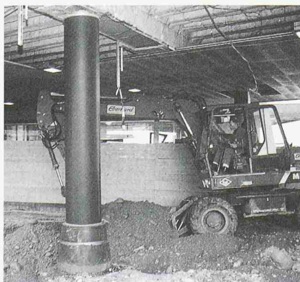
Zu entfernende Stütze unter der Fingerwurzel A während des Aushubs der Baugrube
