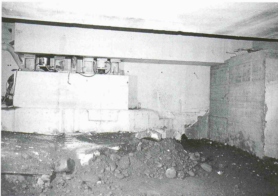
8 Fertiges Tragsystem mit Pfahlbankett, Pressensystem und Träger
