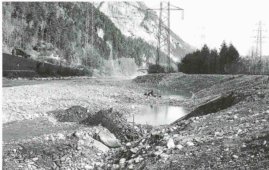
Einrichten von Eidechsen-Habitaten in Form von Stein- und Asthaufen sowie Trockenmauern und Steinkörben im Bereich der Reussdämme
